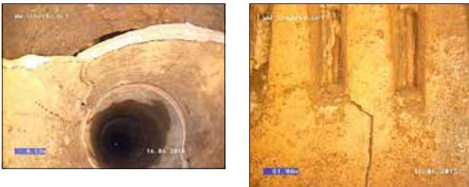
Bild 1 + 2: Kamerabefahrung vom Juni 2015 - Beschädigungen unterhalb des Brunnenkopfes (links) sowie Risse im Bereich des Filterrohres (rechts)
