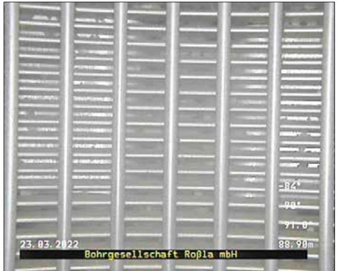
Bild 5: Wickeldrahtfilter im Brunnen
