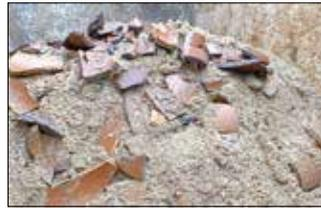
Bild 3: Stückweiser Ausbau der alten Steinzeugverrohrung
